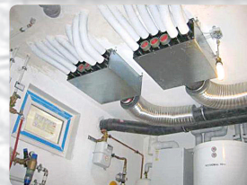
Primer povezovanja distribucijskih kanalov za prostore z glavnim dovodnim in povratnim razdelilcem
