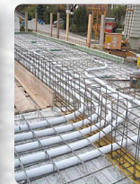
Potek kanalnih povezav nad spuženim stropom ter v armirano betonski plošči
