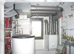
Primer povezovanja distribucijskih kanalov za prostore z glavnim dovodnim in povratnim razdelilcem
