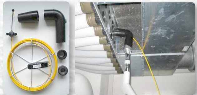
Prikaz možnosti priklopa naprave za čiščenje kanalskega sistema
